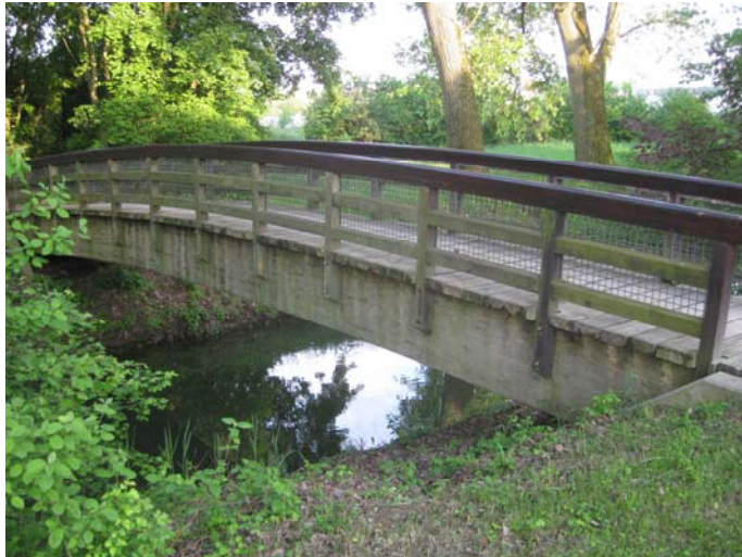
Brücke aus Fichten- brettschichtholz, 2010 abgerissen
