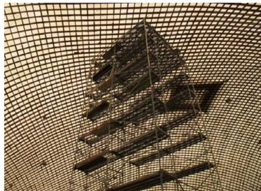
**Bild 22:** Öffentlich zugänglicher Vorraum links und Stützgerüst mit Delle in Gitterschale rechts
