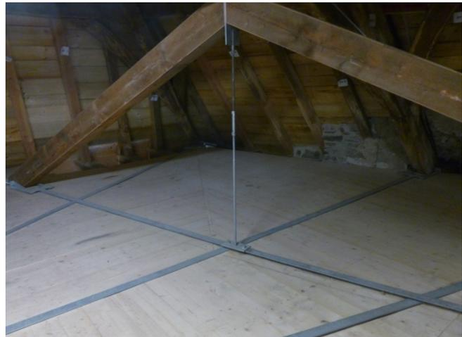
**Bild 15:** Stahlkonstruktion für Kopfbänder links und Hilfskonstruktion rechts
