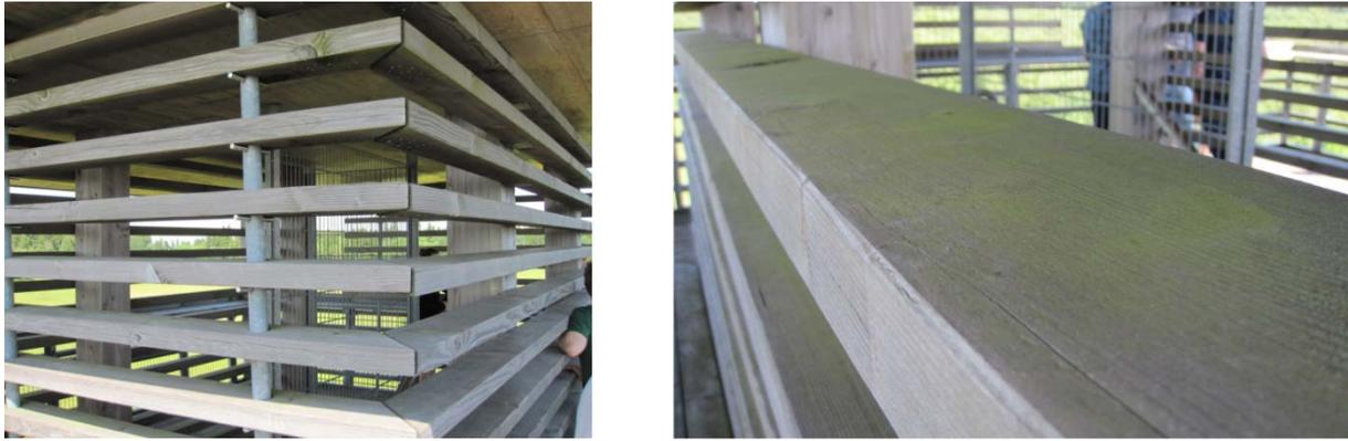
**Bild 3:** Die Verkleidung des Treppenaufgangs links und die Verfärbung des Holzes rechts
