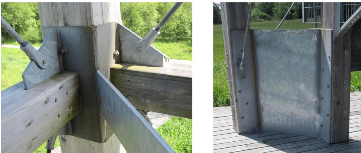
**Bild 4:** Anschluss der Diagonalaussteifung links und Detailansicht des ausgesteiften Fußpunktes rechts
