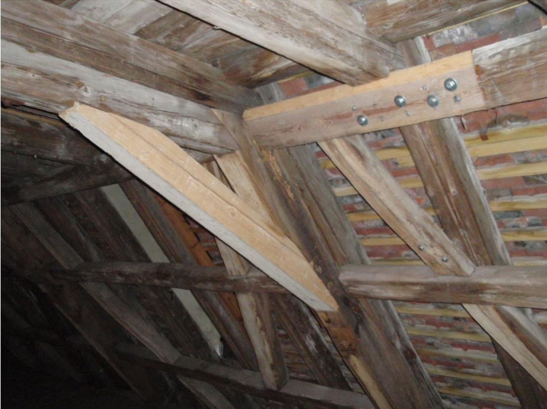
Abbildung 4: Liegender Stuhl mit Reparaturstellen
