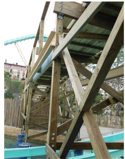
**Abbildung 23:** Die Aussteifung der Fachwerkböcke in Längsrichtung
