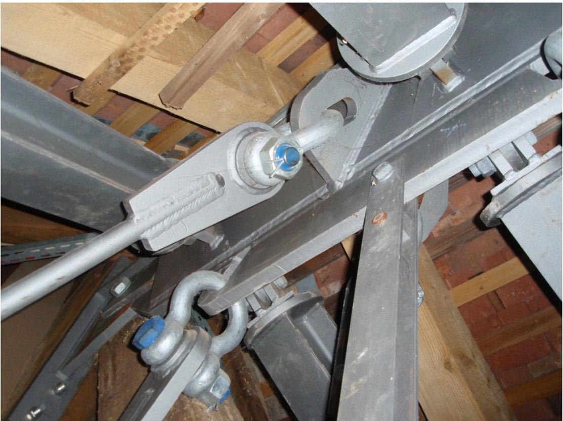
**Abbildung 7: Kopfpunkt Sprengwerk**
