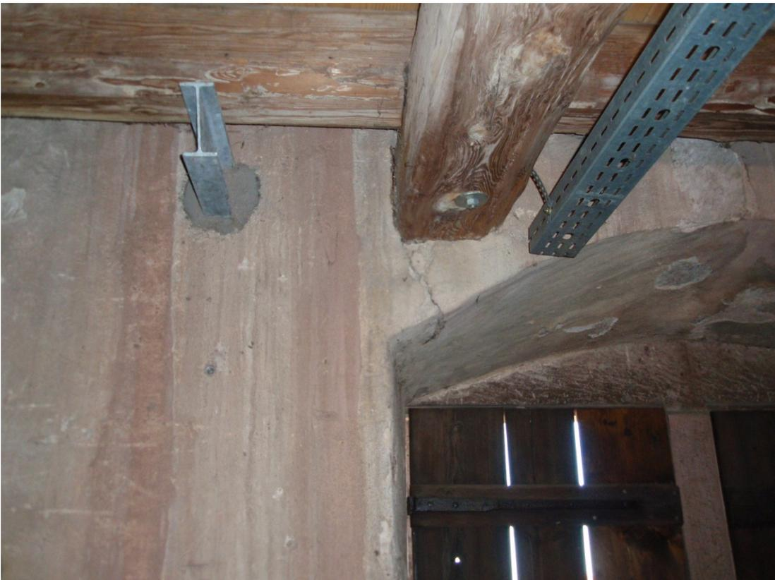
Abbildung 3: Pfettenauflager in Mauerbogen, Schaden und Reparatur mit Stahlaufleger
