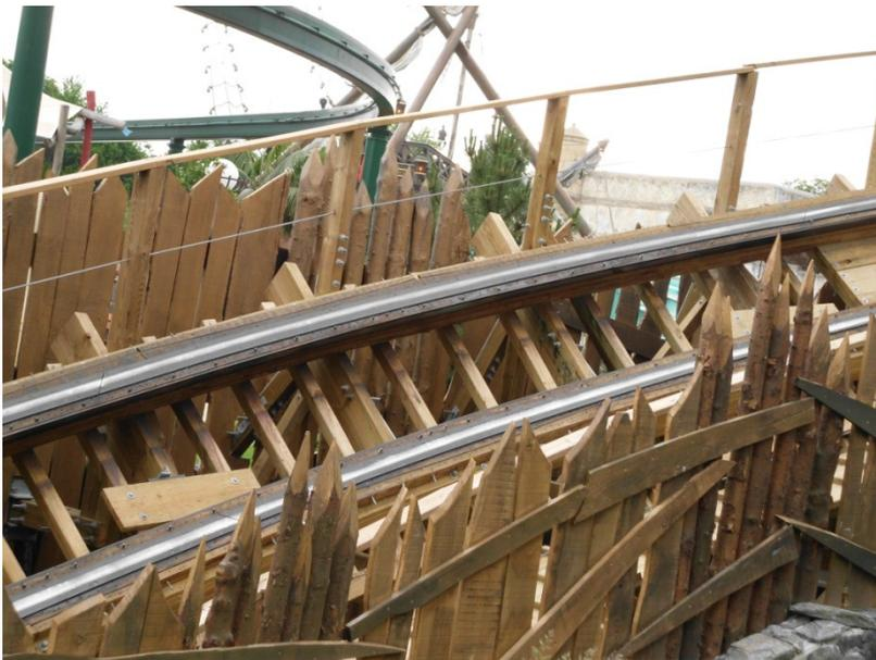
**Abbildung 24: Die Schienenkonstruktion, bestehend aus acht übereinander genagelten Brettern und Stahlbänder als Lauffläche für die Räder**
