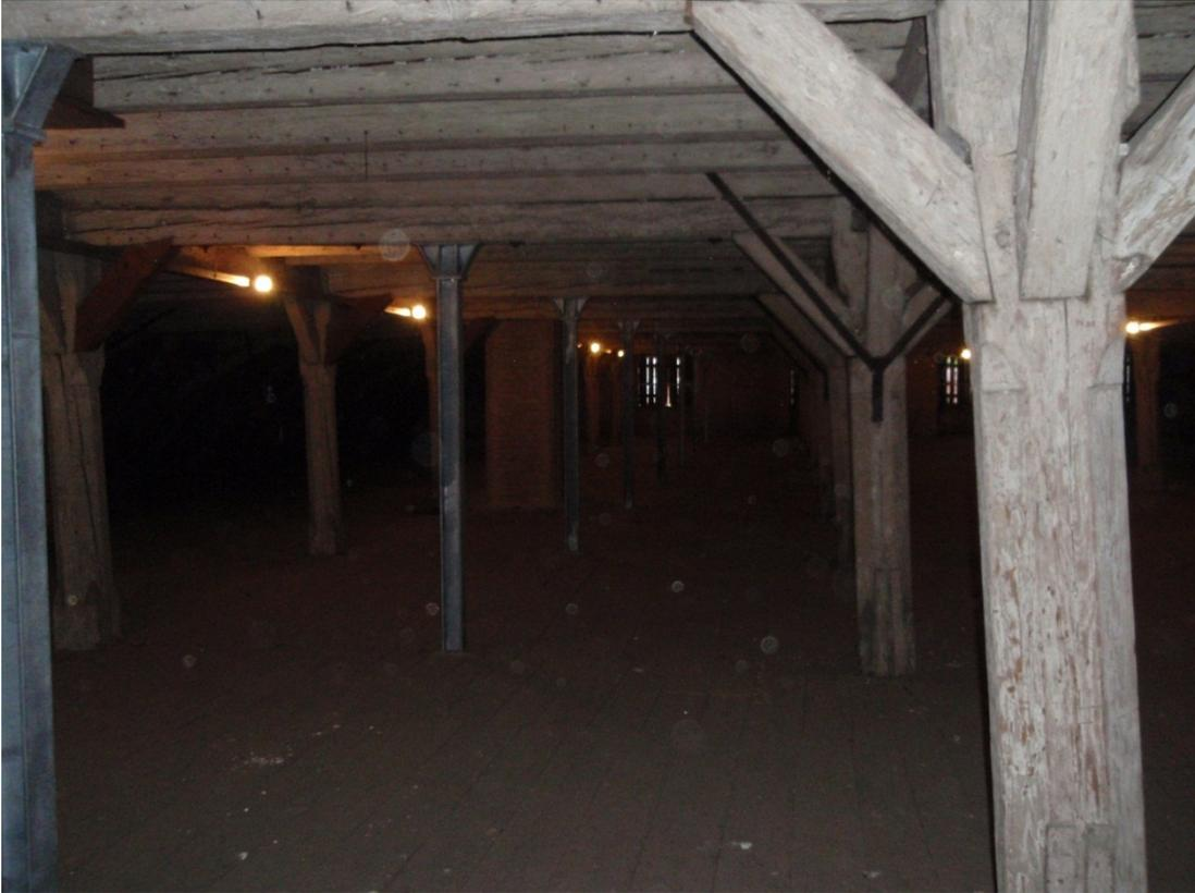
Abbildung 2: Eingebaute Stahlstützen
