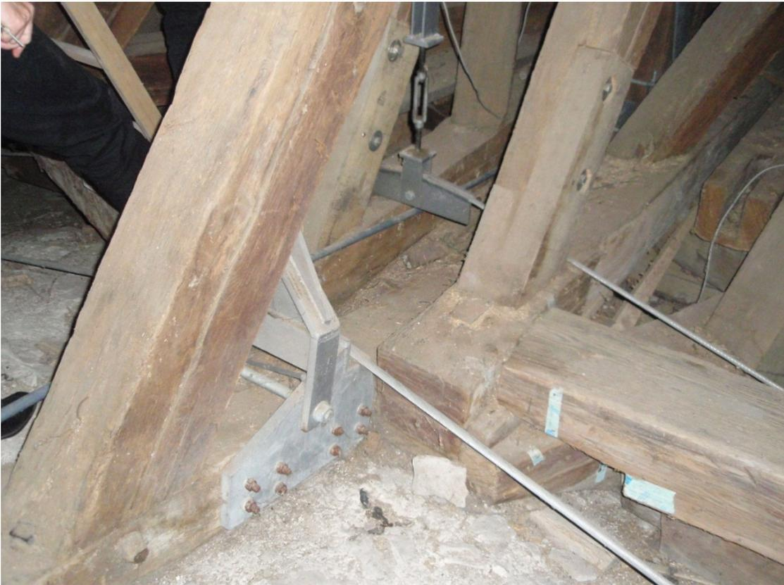
**Abbildung 6: Umlenkung Zugbänder**
