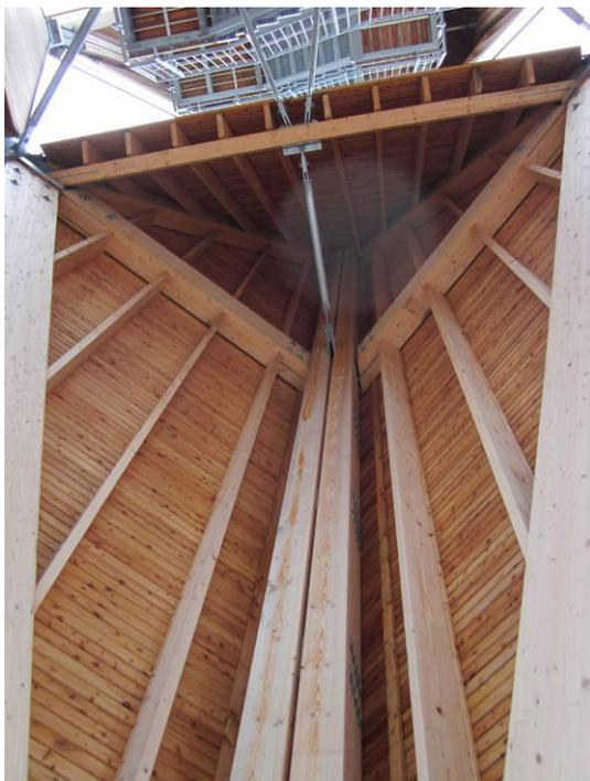
Durch geschickte bautechnische Maßnahmen gelang es dem Architekten den konstruktiven Holzschutz bestmöglich umzusetzen. Zum Einen verzichtete Andreas Moll, wo es möglich war, auf horizontale Flächen. An besonders gefährdeten Stellen wurde die Holzkonstruktion mit Blech verkleidet.
