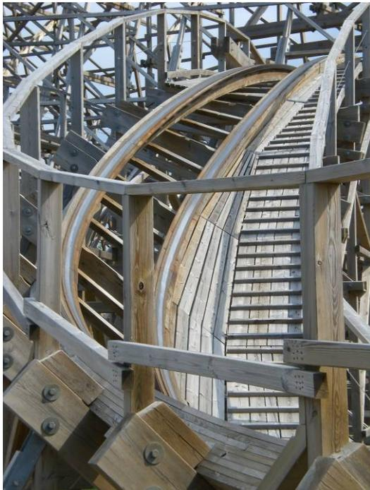
Die 70.000 durchnummerierten Holzbauteile wurden im Sägewerk CNC-gesteuert aus 4000 bis 6000 Kiefernstämmen zugeschnitten. Erst nach dem Zuschnitt und dem Abbund wurden die Hölzer kesseldruckimprägniert. Dadurch wurden die Hirnholzenden und bereits vorhandene Bohrlöcher besser geschützt und weitere Schwachpunkte vermieden. Außerdem entstand kein imprägnierter Abfall. Als Verbindungsmittel wurden bis zu 2 Mio. Schraubnägel und 1 Mio. Schrauben verwendet.
