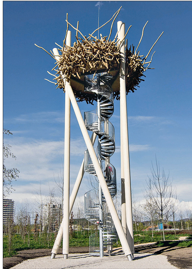
Das „Krähennest“, ein „Accoya“-Rundholzturm mit dem statischen Konzept eines räumlichen Strebenbocks Foto: Holzbau Baumer, Rainer Spaniel
