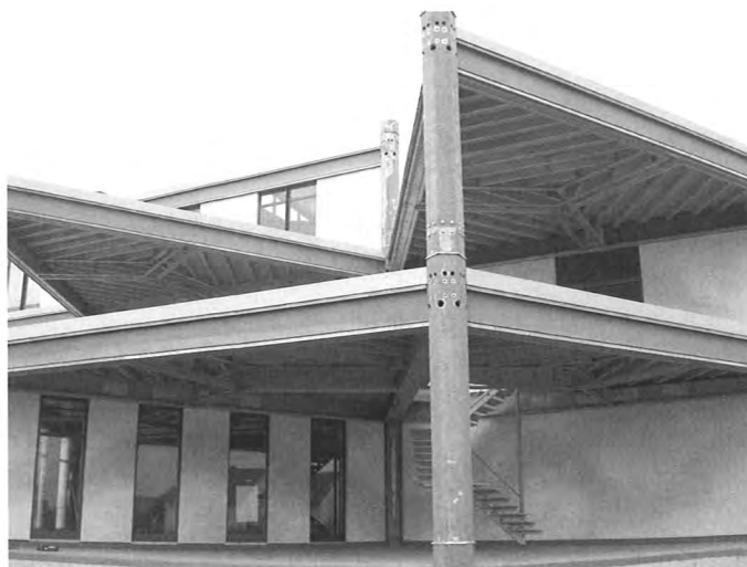
Bild 4: Holz-Beton-Verbund-Decke beim Neubau eines Event- und Ausstellungszentrums – Vorgefertigte Holz-Beton-Verbund-Decken bestehend aus Holzrippen und Betonplatte. Auflagerung der einzelnen Holz-Beton-Verbund-Deckenelemente auf den Stahlträgern über die obere liegende Betonplatte. Unterseitige Verkleidung der HBV-Decke im weiteren Bauablauf mittels einer abgehängten Unterdecke. Foto: Bletz
