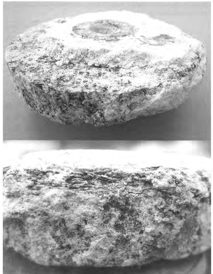
Bild 7: Ringkeildübel GD-AlSi9Cu3 aus tausalzbehandelter Holzbrücke nach 5 Jahren
