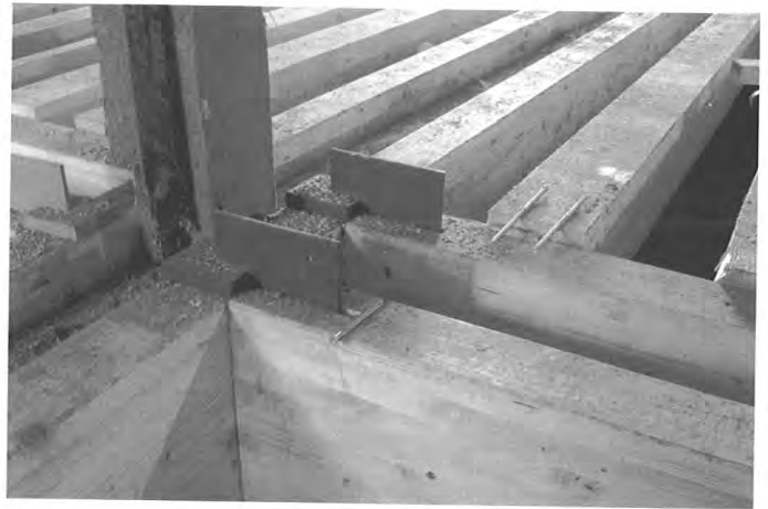
Bild 13 Anschluss der Unterzüge und der Deckenbalken an das Hängewerk
