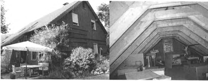
Bild 9 Kein Insektenbefall bei technisch getrocknetem nicht chemisch behandeltem Holz im Innen- und Außenbereich eines rund 20 Jahre alten Holzhauses
