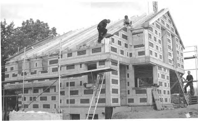
Bild 1 Rohbau eines Wohngebäudes aus vorgefertigten Wandelementen
