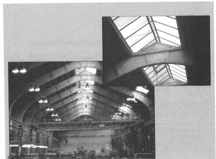
Bild 8 Intakte Hetzerträger ohne Holzschutzmittel, Alter rd. 100 Jahre
