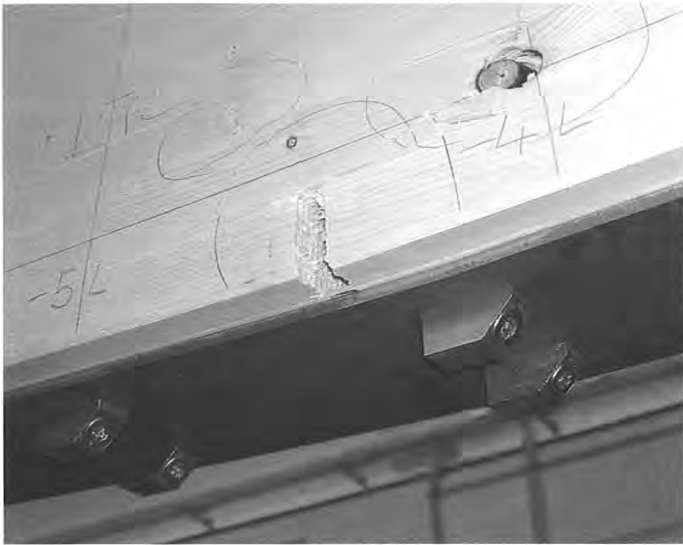
Bild 3 BSH-Träger mit Stahllamelle (S 235) im Bruchzustand: Biegezugversagen des Holzes am Keilzinkenstoß; erkennbar ist die plastische Dehnung der Stahllamelle im Bereich der Lochschwächung und die Ausbildung der Anschlußschuhe für die Diagonalverschraubung
