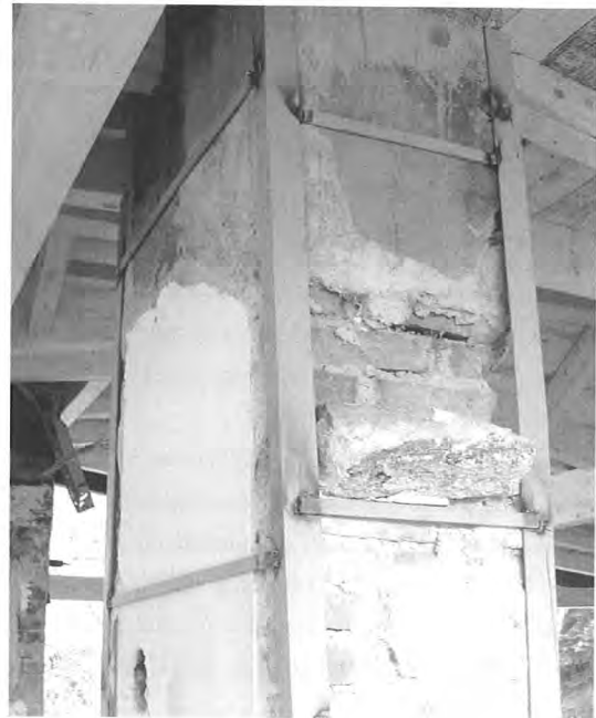
Bild 5 Verstärkter Auflagerpunkt
