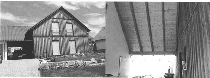
Bild 10 Kein Insektenbefall bei technisch getrocknetem nicht chemisch behandeltem Holz im Außenbereich eines rd. 15 Jahre alten Holzhauses
