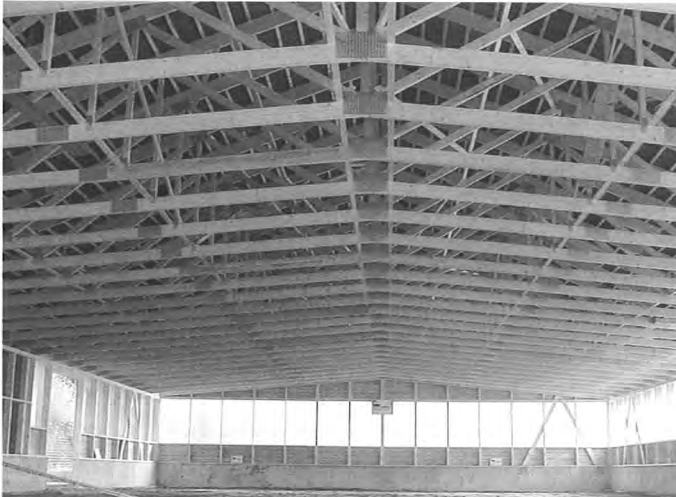
Bild 1 Fachwerkträger aus Vollholz mit Nagelplattenverbindungen
