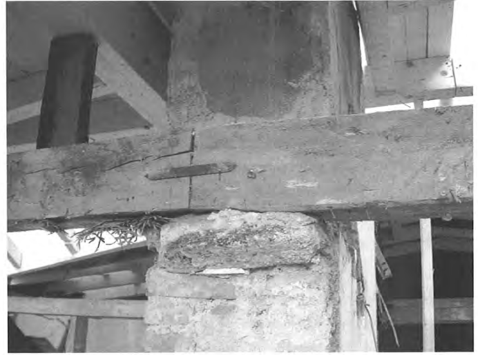
Bild 2 Ferienhaus Höfer: Die Mittelfette lagert auf einer Steinkonsole auf, die aus einem gemauerten Kaminpfeiler herausragt.
