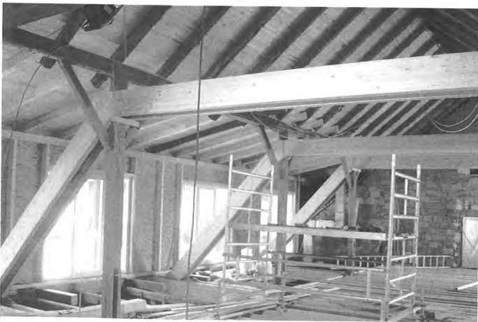
Bild 9 Beidseitig verstärktes Tragwerk
