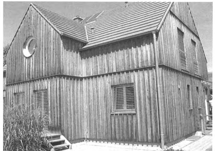
Bild 18 Ausreichende Spritzwasserfreiheit einer Holzfassade
