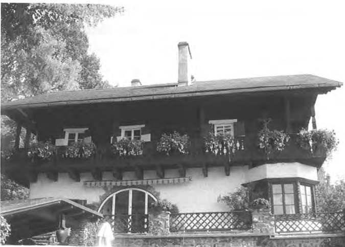
Bild 4 Ferienhaus Höfer bei Millstatt vor dem Umbau
