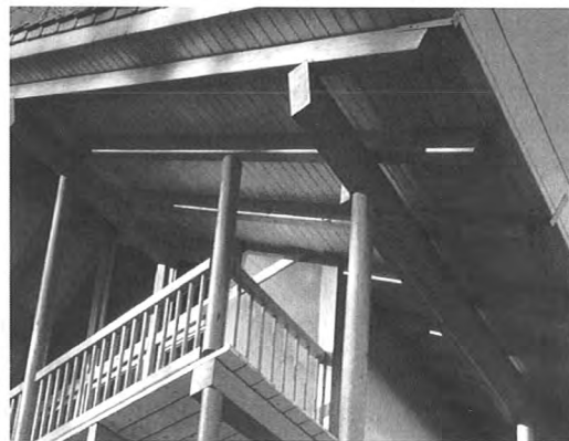
Bild 4 Ausreichender Wetterschutz einer Holzkonstruktion
