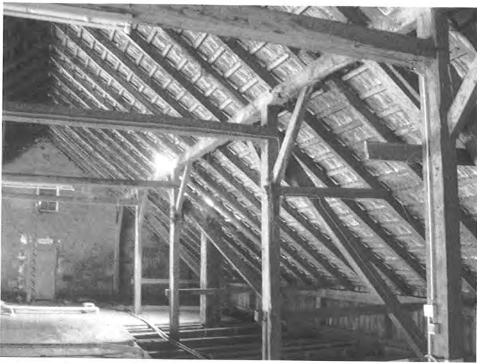
Bild 8 Stehender Stuhl mit doppeltem Hängewerk
