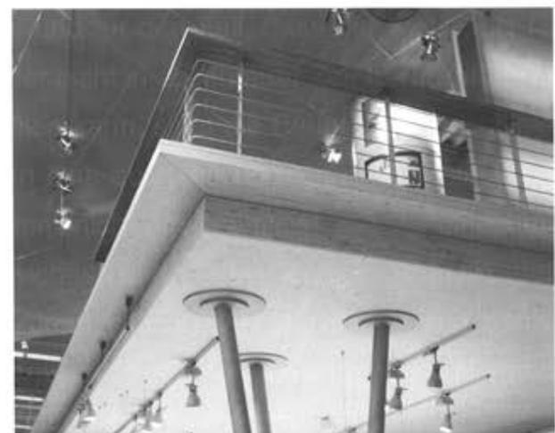
**Abb. 39:** Themenebene DaimlerChrysler, Rastatt (D): Deckenelement mit „Durchstanzverstärkung“ aus Merk Dickholz®
