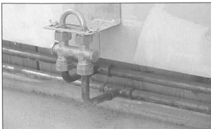
*Abb. 4-11: Heizungsinstallation oberhalb der Fußbodenkonstruktion*
