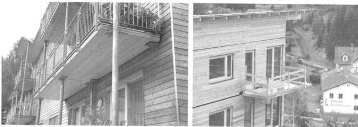
**Abb. 2-4:** Einsatz von BSP als Balkonplatte
