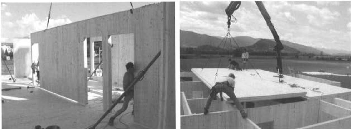
**Abb. 2-2:** Rohbau: Versetzen von Wänden, Einheben von Decken
