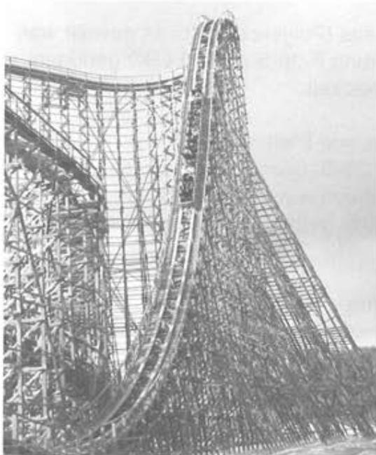
Abb. 11: Achterbahn Heidepark Soltau (D): Montage Treppen auf Holzgerüst, Schienen aus Furnierschichtholz
