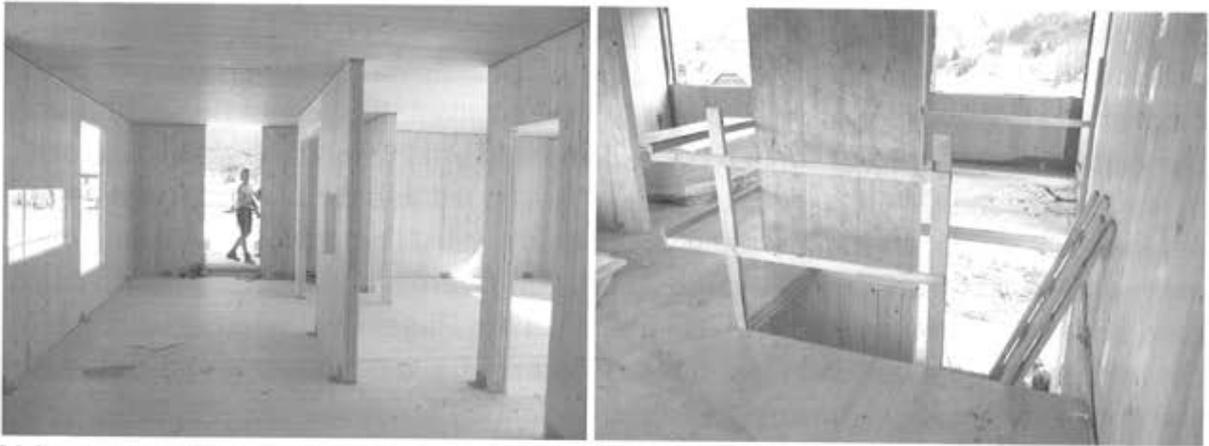
**Abb. 2-3:** Raum: Tragende und aussteifende Wände und Decken mit Öffnungen
