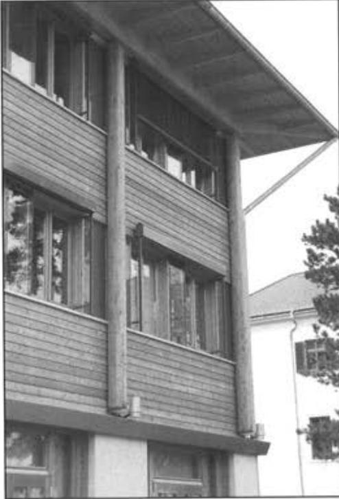
*Abb. 4-18: Lärchenrundholzsäulen an der Fassade*
