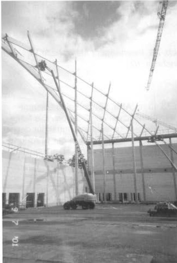
**Abb. 23:** Neue Messe Friedrichshafen (D): Aufbau Zollinger-Schale Mehrzweckhalle
