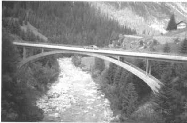
**Abb. 40:** Pünt la Resgia über den Averser Rhein bei Innerferrera (CH) Straßenbrücke für forstwirtschaftlichen Verkehr mit dahinter liegender Stahlbeton-Bogenbrücke
