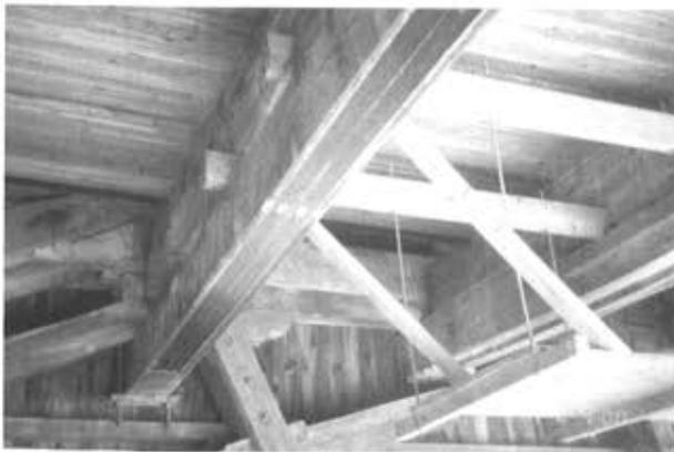
**Abb. 42:** Bogenbrücke über die Reuss bei Sins (CH): Unteransicht - einlagige Verstärkung Querträger mit zwei CFK-Lamellen
