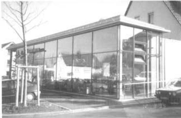
**Abb. 36:** Sparkasse Filderstadt-Stetten (D): Rahmen-Tragkonstruktion aus Parallam
