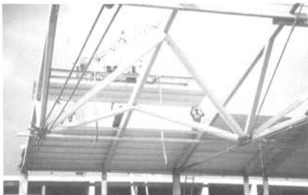
**Abb. 15:** Grundschule Aichach-Nord (D): Innenansicht räumliches Tragsystem Mehrzweckhalle
