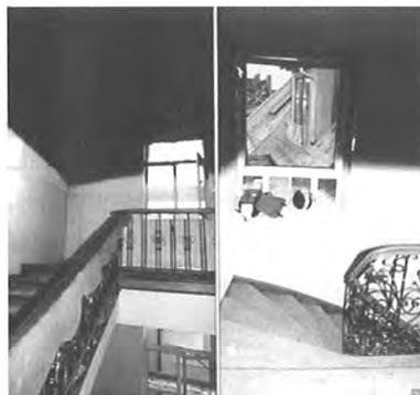
Funktion von Treppenraumfenstern an Außenwänden als Rauch- und Wärmeabzugsvorrichtungen: Es wurde nur der Treppenraum oberhalb des geöffneten Treppenraumfensters verrauchert. Der Bereich darunter blieb rauchfrei und stand damit als Flucht- und Rettungsweg zur Verfügung.
