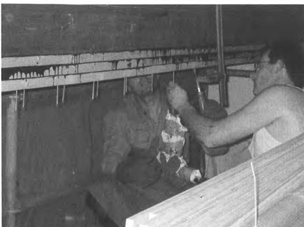
**Bild 23 Unterkleben von Lamellen mit Schraubpressklebung**
