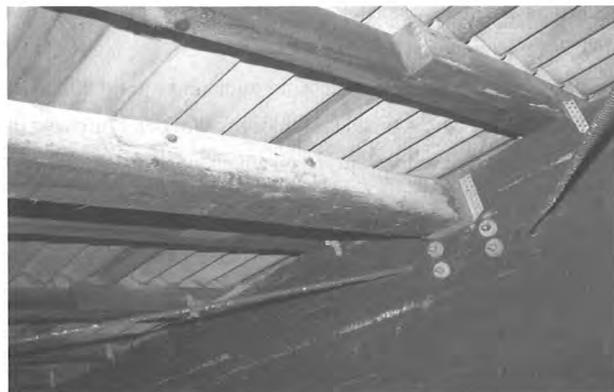
Bild 4 Algenbewuchs auf dem Querverband und Korrosion an den Aussteifungen
