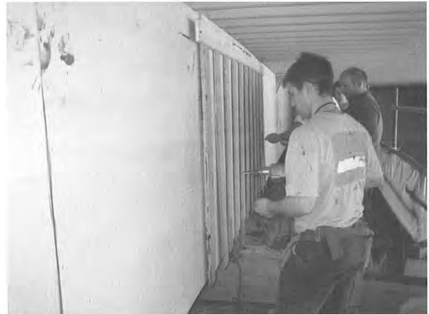
Bild 21 Zweimal 15 mm Sperrholz auf Binder über einem Kesselhaus
