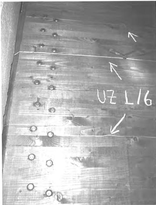
Bild 2 Abspernung des Endquerschnittes durch Stabdübel
