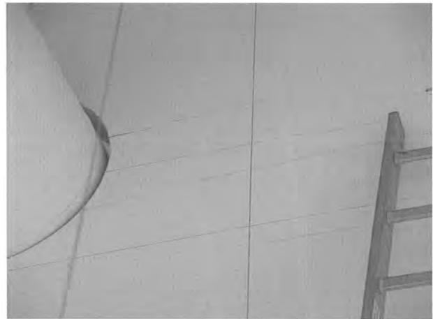
Bild 28 Risse an einem mit Gewindestangen verstärkten Durchbruch
