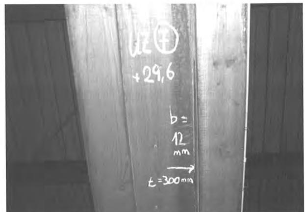
Bild 5 Blockfuge eine Kastenträgers, Verklebung mit Harnstoffharzleim
