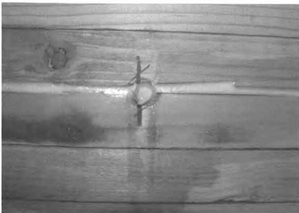
Bild 17 Vorgeschnittene Fuge mit Einfüllventil
