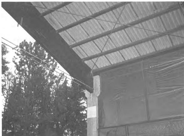
Bild 3 Nordostecke der Halle; Betonsäule mit Gabellager, Brett-schichtholzträger, Koppelpfetten, Auskreuzungen, Unterzug, sowie nachträglich angebrachter Windschutz aus Kunststoff-Planen
