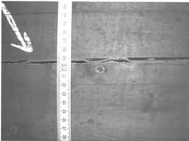
Bild 6 Mittige Verklebung der Stege des Kastenträgers mit Harnstoffharzleim
