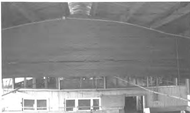
Bild 9 Querzugversagen eines Satteldachbinders
