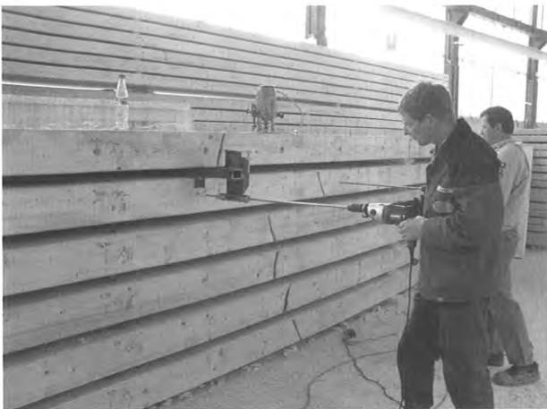
Bild 26 Einbau von Gewindestangen
