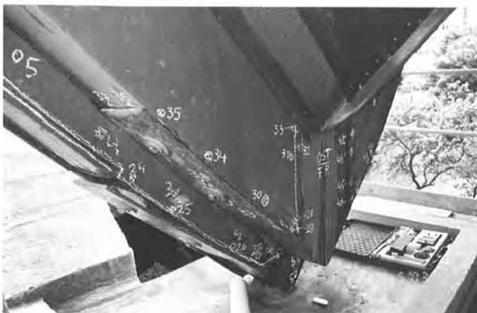
Bild 50: Fußpunkt mit Stahlschuhen und Markierungen der Bohrwiderstandsmesspunkte.
