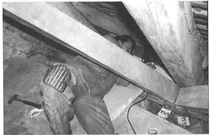
Bild 40: Ausführung einer Bohrwiderstandsmessung an einem Deckenbalkenkopf.
