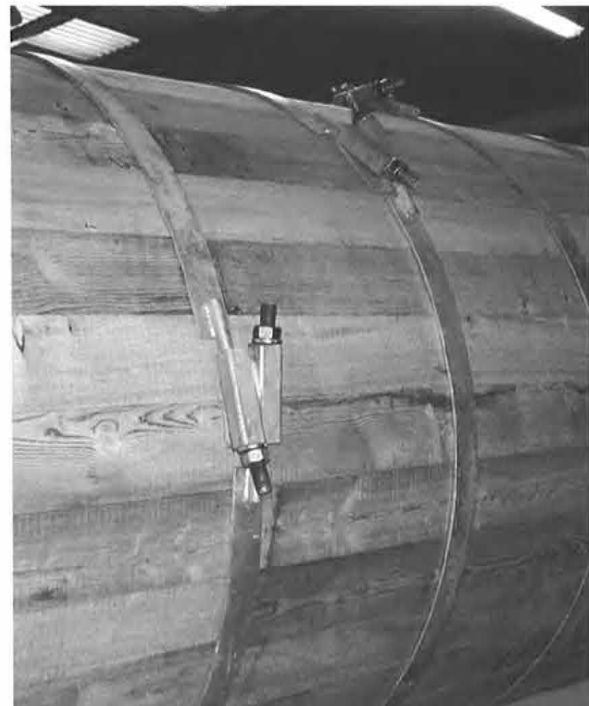
Bild 8: Anordnung der Spannringe
