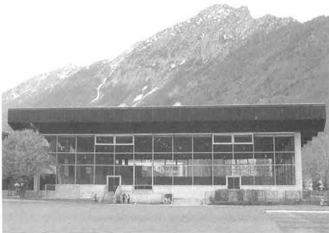
Bild 1: Eishalle Bad Reichenhall
