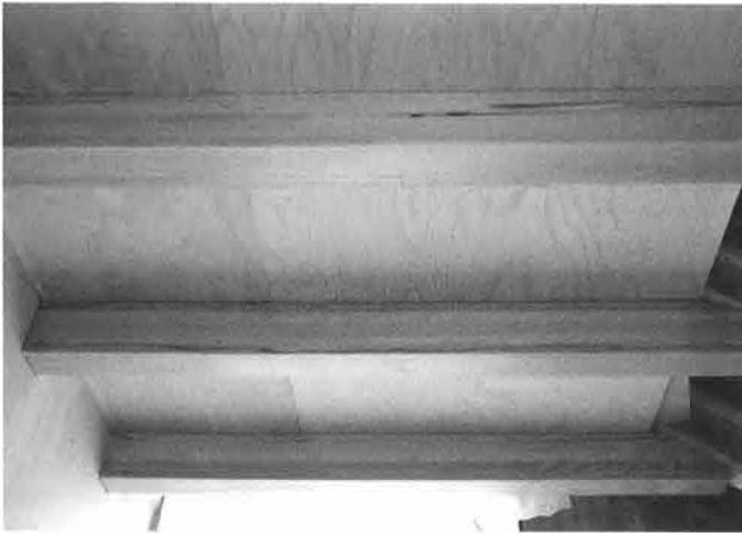
Bild 14: Einsatz von BSH aus Buche im Hausbau: Balkenlage mit Beplankung aus Baufurniersperrholz aus Buche, Aufnahmen Ralf Burkhardt
