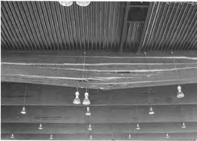
Bild 8: Eissporthalle, Brettschichtholz mit Harnstoffharzkleber
