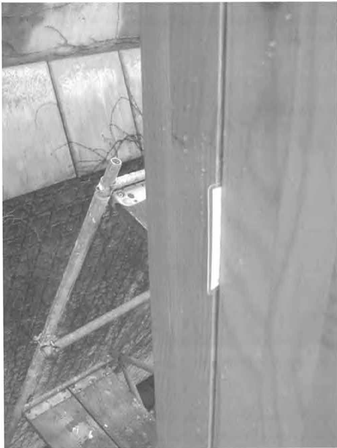
Bild 11: Delaminierendes Stück Brettstichholz aus Lärche
