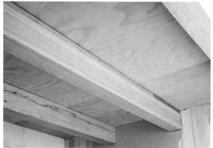
Bild 14: Einsatz von BSH aus Buche im Hausbau: Balkenlage mit Beplankung aus Baufurniersperrholz aus Buche, Aufnahmen Ralf Burkhardt
