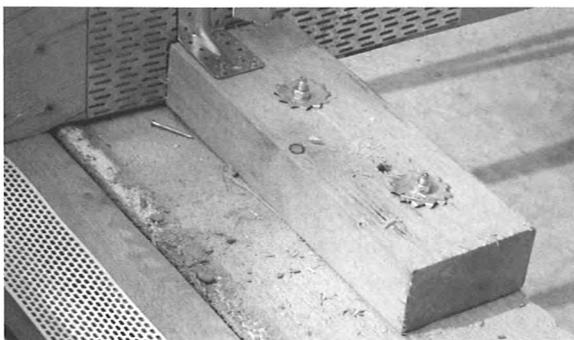
Bild 9: Weiterleitung der Horizontallast aus dem Aussteifungsverband über eine Knappe an das Stahlbetonrähm „mit Hilfe“ einseitiger Dübel besonderer Bauart
