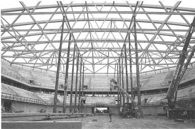
Bild 6: Teilweise montierte Dachtragkonstruktion im abgestützten Zustand. Die Baumstützen tragen eine Last von ca. 25 t.
