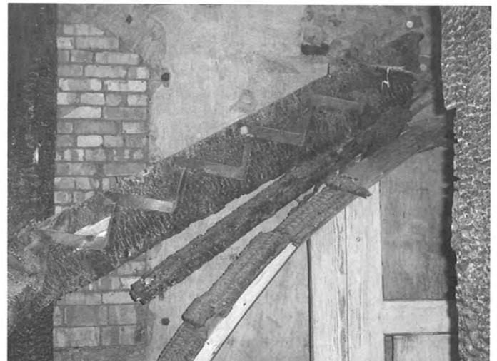
Bild 7: Weitgehend zerstörte Treppe vom Rokokosaal zum 1. Dachgeschoss (Foto: Verf.)
