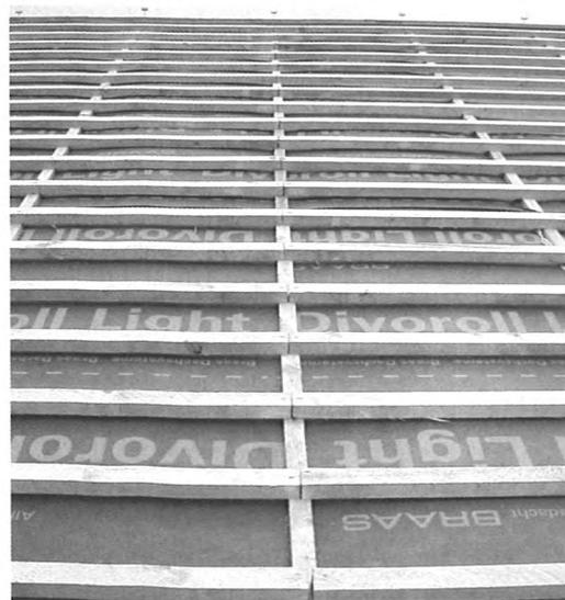
Bild 10: Versetzen der Dachlattenstöße
