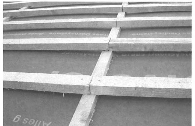
Bild 11: Nagelabstände an den Stoßstellen?
