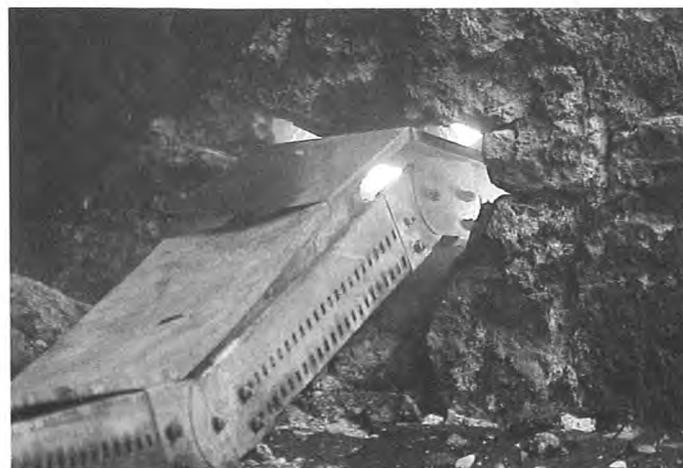
Bild 11: Kabeldurchführung im 2. Dachgeschoss nach dem Brand (Foto: E. Arnhold)
