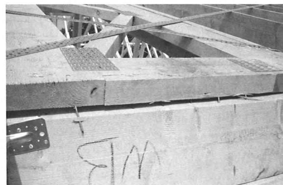
Bild 6: „Anschluss“ des Aussteifungsverbandes an die Verblockung
