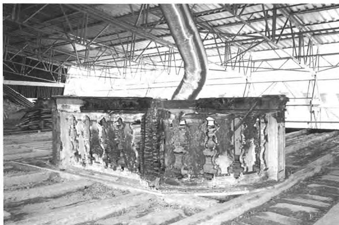
Bild 17: Notdach und Rauchableitung (Foto: Verf.)
