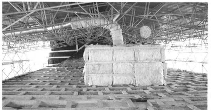
Bild 22: Stabilisierung der Deckenbereiche (Foto: Verf.)
