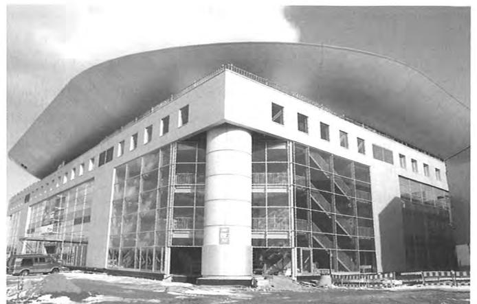
Bild 13: Dachranduntersicht im Eckbereich. Die Abmessungen und Winkel der Alucobondplatten sind für eine Ecke alle unterschiedlich.
