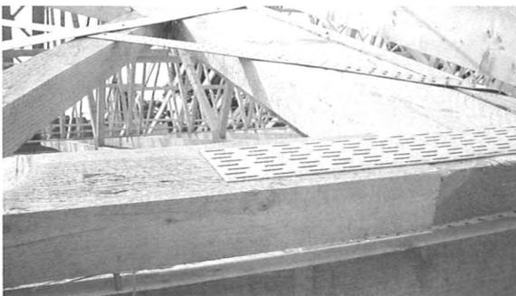
Bild 8: „Anschluss“ des Aussteifungsverbandes an die Verblockung
