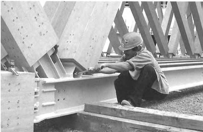
Bild 10: Anschluss der einteiligen Diagonalen- und zweiteiligen Holzuntergurtquerschnitte am Stahluntergurtknoten mittels BVD-Anker
