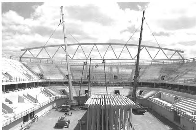
Bild 7: Montage des Randbinders mit 2 Kränen. Im Vordergrund stehen bereits einige vormontierte Binderhälften.
