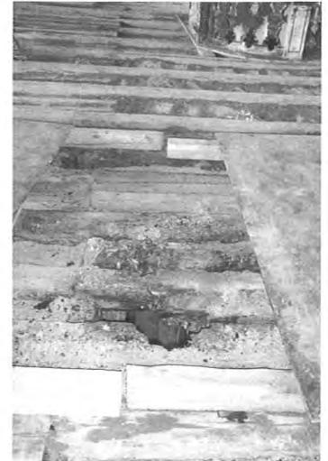
Bild 12: Lokalisierter Bereich des Branddurchbruchs (Foto: Verf.)
