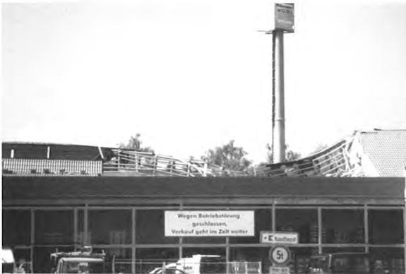
Bild 22: Teileinsturz eines Daches in Nagelplattenbauweise
