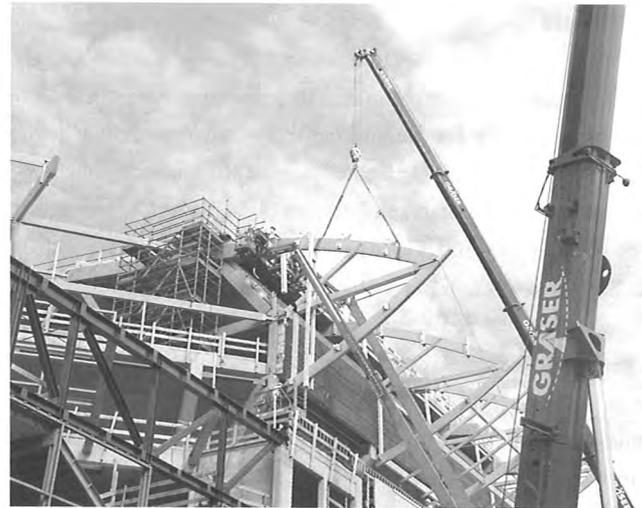
Bild 11: Montage der ausragenden Fachwerkschnäbel an die innere Dachtragkonstruktion. Die Leichtdachelemente sind bereits verlegt.
