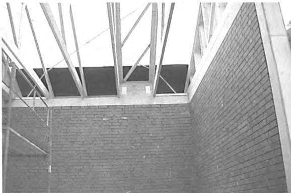
Bild 15: Falscher Verlauf von Windrispenbändern
