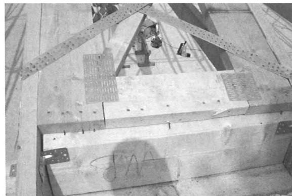
Bild 5: „Anschluss“ des Aussteifungsverbandes an die Verblockung
