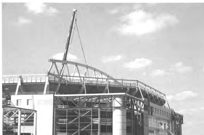
Bild 8: Zur Stabilisierung der einzelnen Pedelstützenköpfe werden diese auf die nächste tiefer gelegene Massivbauebene abgestützt.
