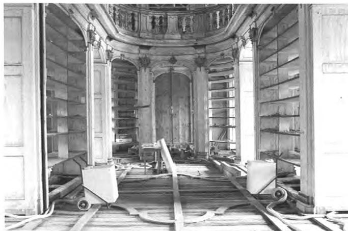
Bild 18: Technische Bautrocknung nach Freilegen der Konstruktion (Foto: Verf.)
