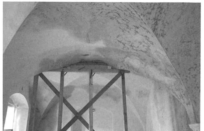
Bild 8: Wasserschäden im Erdgeschoss durch Löscharbeiten (Foto: Verf.)
