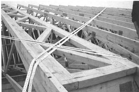
Bild 16: Falscher Verlauf von Windrispenbändern
