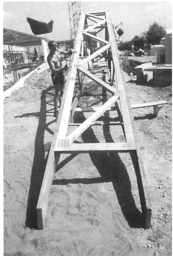
Bild 2: Nagelplattenbinder mit Aussteifungsverband
