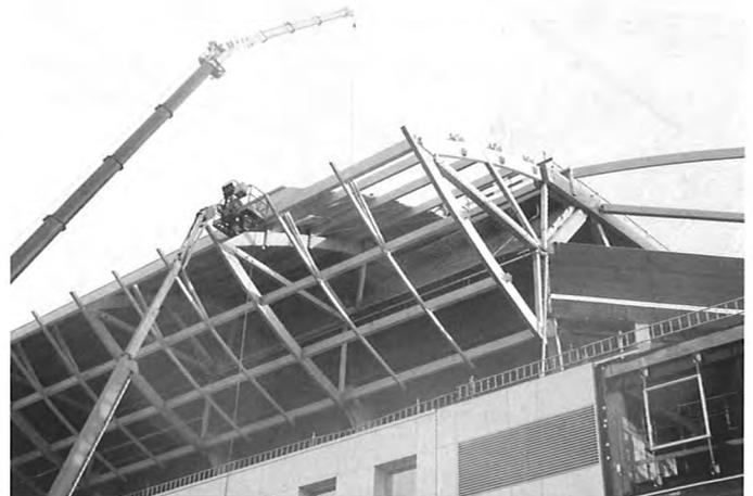
Bild 12: Montage der 42 mm dicken, oberen Schalungselemente im geraden Längsbereich
