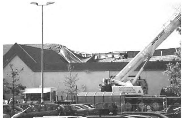
Bild 23: Teileinsturz eines Daches in Nagelplattenbauweise
