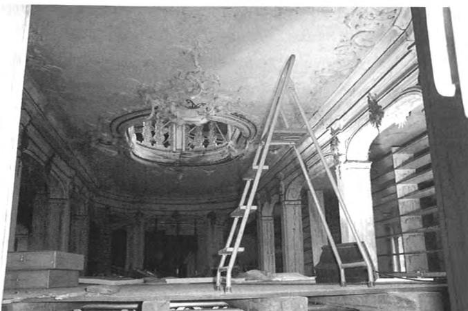
Bild 5: Die Decke des Rokokosaals hielt der über 3stündigen Brandbelastung stand (Foto: Verf.).
