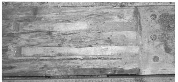
Bild 23: Anwendung des Beta-Verfahrens (Foto: Verf.)
