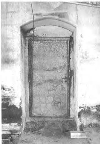
Bild 10: Brandmauer mit Türblatt (im 1. Dachgeschoss) aus dem 19. Jahrhundert (Foto: Verf.)
