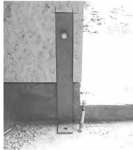
Bild 1: Anschluss eines Zugankers nach Norm
