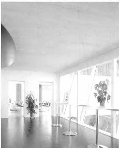
5. Beispiel: Zwischenbau Gasthaus zum Höchsten Trotz tragender Funktion, gleiche Deckenuntersicht wie in den Seminarräumen. Tragen, Dämmen, Absorbieren mit einem Element
