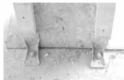
Bild 2: Anschluss von Zugankern mit Zwischenschicht
