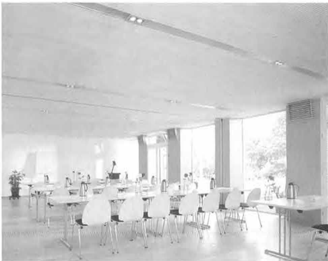
5. Beispiel: Seminarbereich Gasthaus zum Höchsten ruhige plane Deckenuntersicht mit optimaler Absorption und integrierten Lichtbändern
