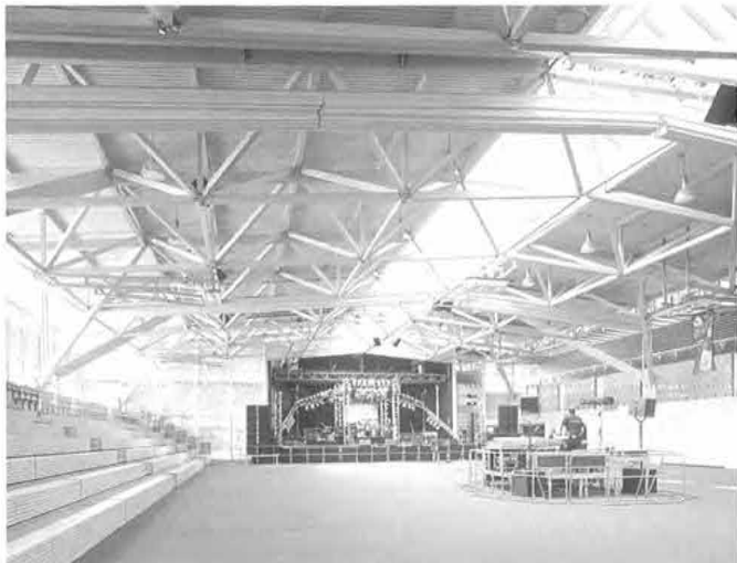
Bild 9: Dachelemente als Folienabsorber
