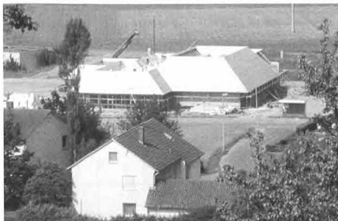
1. Beispiel: Mehrzweckhalle Illmensee. Trotz günstiger Dachform und überwiegender Verkleidung mit gehobelter Fichteschalung zu lange Nachhallzeit
