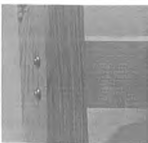
Bild 19: HaSe-Ankerbolzen: Hirnholzanschluss mit Spreizdübel
