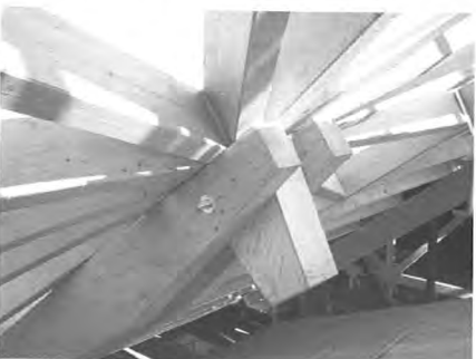
Bild 29: Betonknoten mit innenliegenden Gewindehülsen vorgefertigt, Stäbe mittels „Rückverankerung“ von der „Holzseite“ aus angeschlossen
