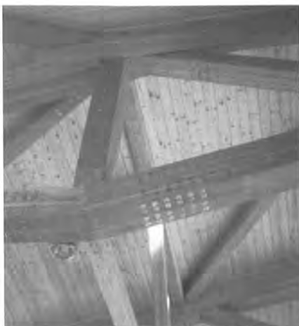
Bild 24: BVD-Verbindung: kreuzweise Pass-Bolzen, Behinderung des Spaltens durch „Umreifung“ mit Klemmscheiben
