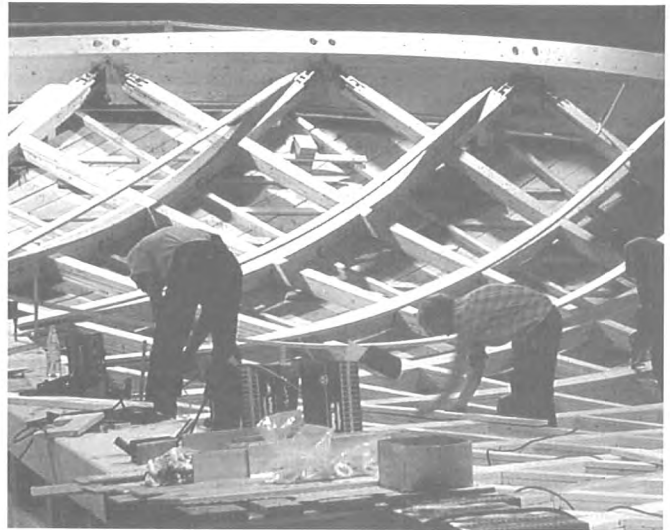
Bild 3.4: Verpressung mit selbstbohrenden Schrauben
