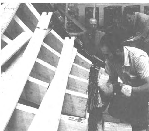
Bild 3.3: Klebstoffauftrag auf die Lamellen einer Schalensippe
