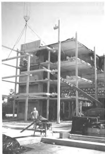
Bild 4: Montage der Stahlkonstruktion und Holzdeckenelemente
