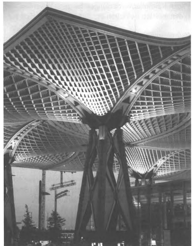
Bild 3.1: EXPO-Dach auf dem Messegelände in Hannover. Die ersichtlichen Schalenrippen wurden mit Hilfe der Schraubenpressklebung hergestellt.
