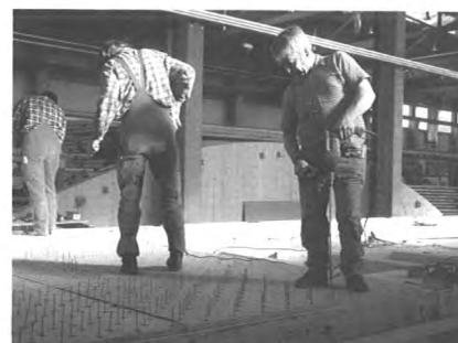
Bild 3.6: Verklebung der Beplankung der Kragträger mit der Holzunterkonstruktion mit Hilfe der Schraubenpressklebung
