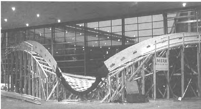
Bild 3.2: Lehrgerüste zur Erzeugung der gewünschten Schalenform
