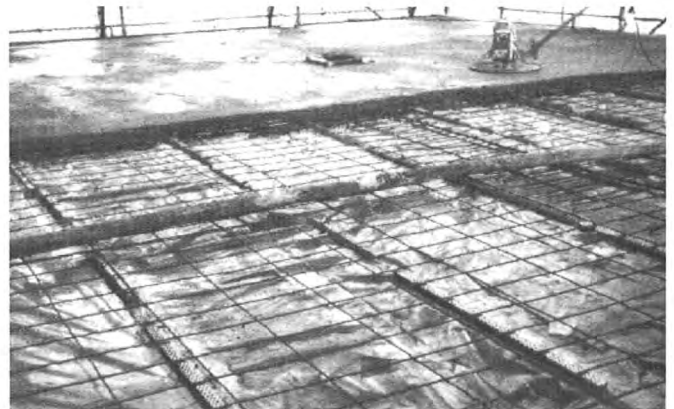
Bild 4.2: Betonieren einer mit eingeklebten Schubverbindern vorbereiteten Holzbalkendecke
