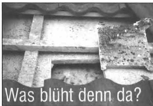
Bild 5 Schimmelpilzbildung auf der Innenseite einer diffusionsoffenen MDF-Platte
