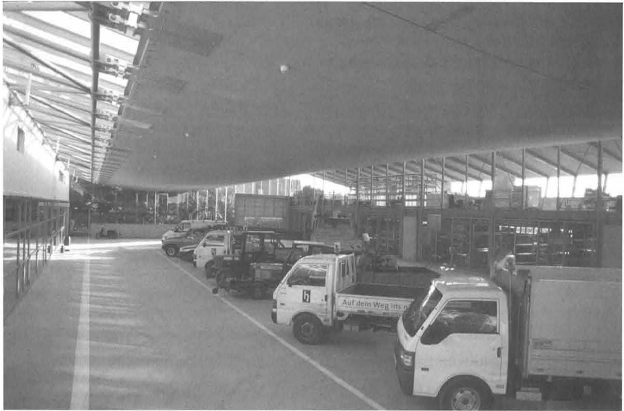
Bild 5: Fahrzeughalle mit Hängedach
