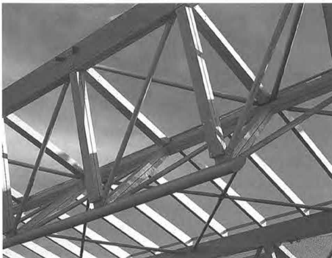
Bild 6: In jedem Fachwerkträger sind 60 t Holz und 60 t Stahl verbaut.
