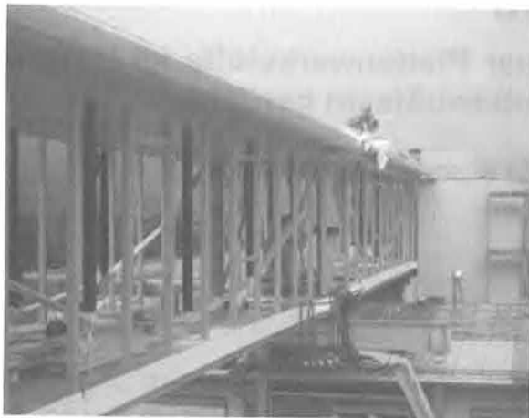
Bild 2: OSB als Konstruktionsplatte für eine Fußgängerbrücke, Egger St. Johann
