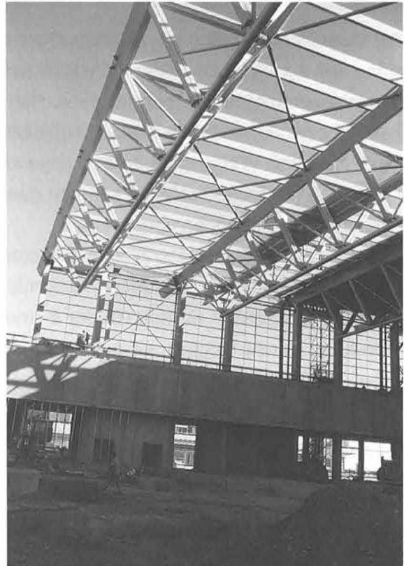
Bild 11: Trotz der riesigen Dimensionen ein filigranes Dachwerk. Errichtet in zwei Monaten.
