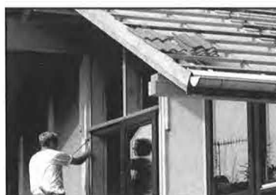
Bild 1: Rohbau eines Holzrahmenbaugeschäftes mit diffusionsoffener Gebäudehülle
