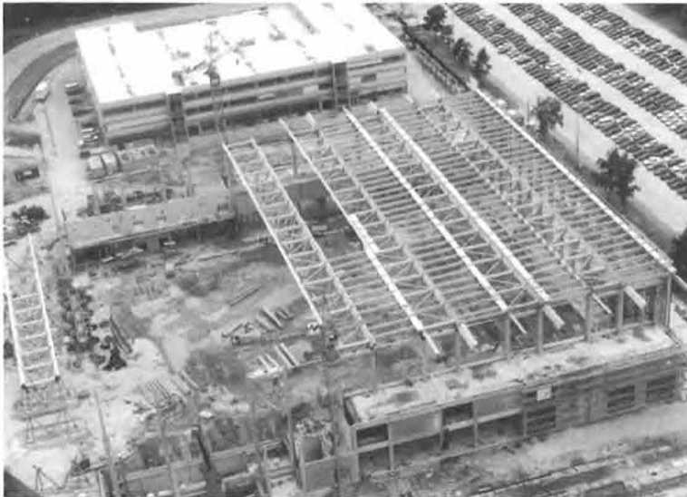
Bild 3: Während der Bindermontage. Insgesamt sechs Fachwerkbinder werden das Dachtragwerk bilden. Der Zusammenbau der Fachwerkbinder erfolgte auf der Baustelle.
