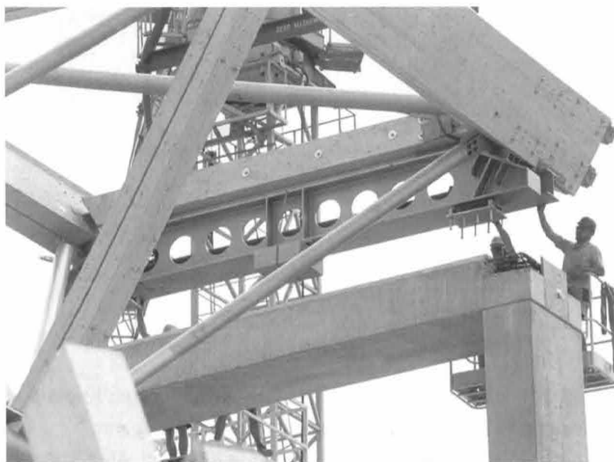
Bild 10: Montage der Auflagertraversen. Die riesigen Dimensionen werden erst im Vergleich mit dem menschlichen Maß deutlich.
