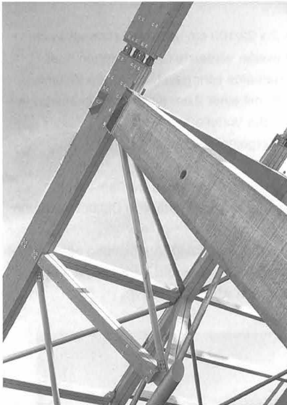
Bild 9: Die durchgesteckten Blech-Anschluß-Fahnen der stählernen Zugstäbe ragen aus dem Obergurt.
