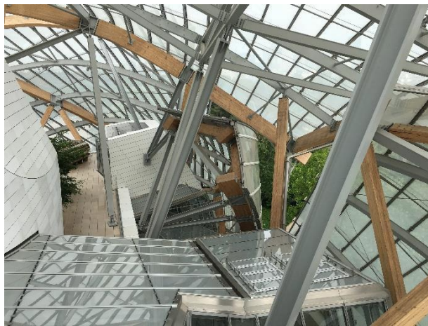
Tragkonstruktion der Glassegel
