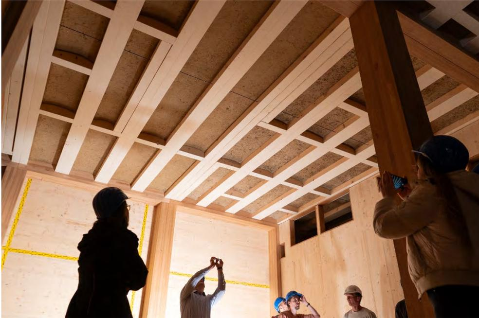
**Abbildung 15:** Unteransicht von Holz-Lehm-Verbund-Decke.
