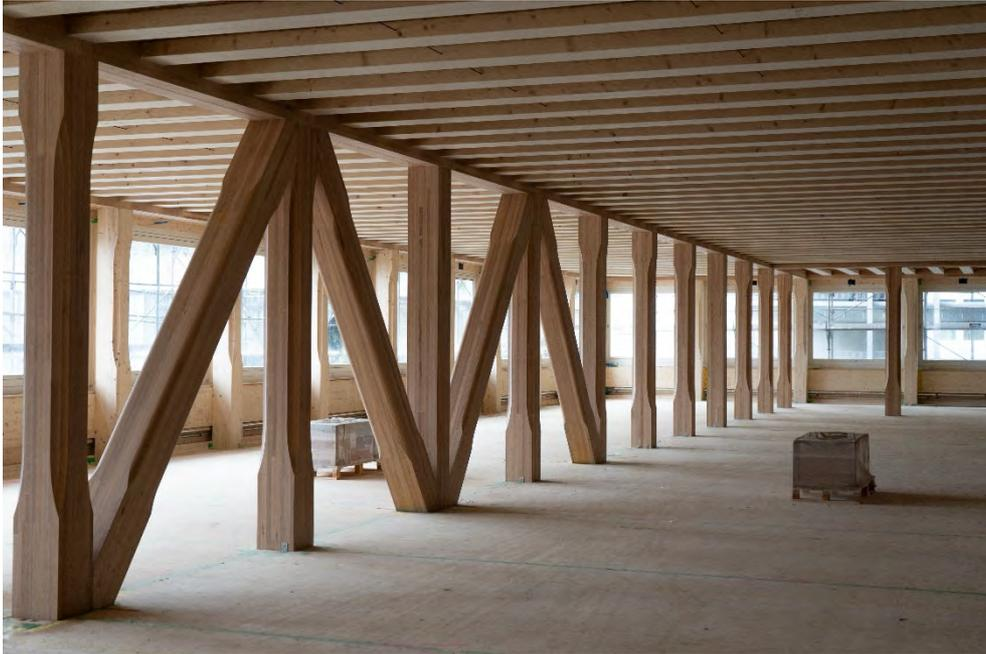
**Abbildung 16:** Tragende Konstruktion und Aussteifung in Längsrichtung.
