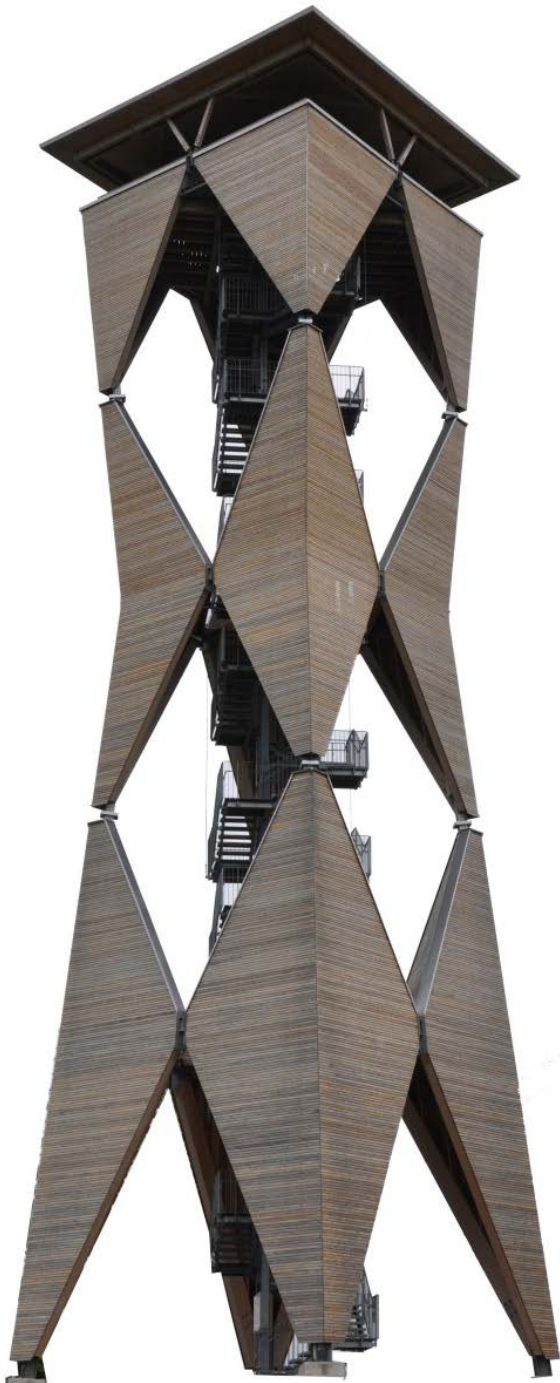
Altenbergturm bei Hohenberg
