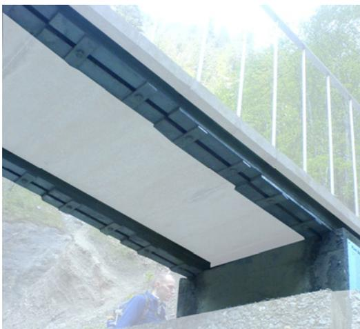
Der Oberbelag der Brücke besteht aus Andeerer Granitplatten mit dazwischen liegenden Aluminiumstreifen um einen kraftschlüssigen Verbund zu gewährleisten. Somit ist es der Brücke möglich, große Schwingungen zu ertragen. Die Platten sind mittels Edelstahlstangen, die als Geländerstangen fungieren, an den Stahlzuggliedern befestigt. Ungeduldig wurde unmittelbar das Schwingungsverhalten und die Eigenfrequenz der Brücke
