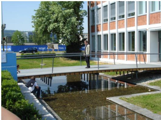
Randlamellen aus Eiche. Der Träger ist für eine bessere Lastverteilung bei großen Einzellasten in seiner Querrichtung vorgespannt. Die Vorspannung ist nicht wie üblich mit Gewindestangen, sondern aufgrund der großen Erfahrung und dem gewollten Verzicht auf den Werkstoff Stahl mit Bändern aus Kohlenstofffasern realisiert. In Längsrichtung ist eine Unterspannung ebenfalls aus CFK-Bändern sowie Druckstreben aus einem GFK-Verbundwerkstoff angeordnet.
