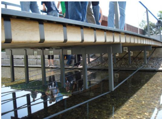
Der Träger wird im Vorfeld durch eine Vierpunktbiegung belastet, so dass sich die Bogenform ergibt. Anschließend werden – im belasteten Zustand – die Unterspannung und die Druckstreben an den Träger montiert und wieder entlastet. Auch der Gehbelag und das Geländer
