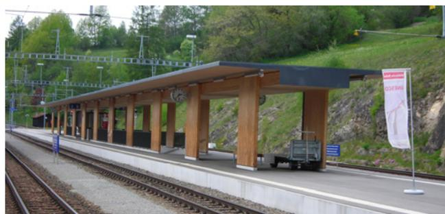
Die Überdachung wurde zu Teilen vorgefertigt an die Baustelle geliefert und dort in drei Etappen zusammengesetzt. In jeder Etappe wurde jeweils ein Drittel der Gesamtkonstruktion montiert. Die Kranarbeiten wurden in 4 Nächten (22:00 – 05:00 Uhr) durchge-
