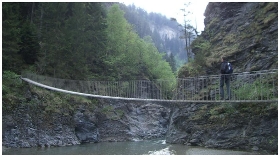
Widerlager aus Stahlbeton halten die vorgespannten Stahlzugglieder fest, die über ein dem Eisenbahnbau entlehntes Gelenk führen. Ziel dieses Gelenkes ist die Vermeidung von einem Bruch durch eine scharfe Kante bei Schwingungen der Brücke.
