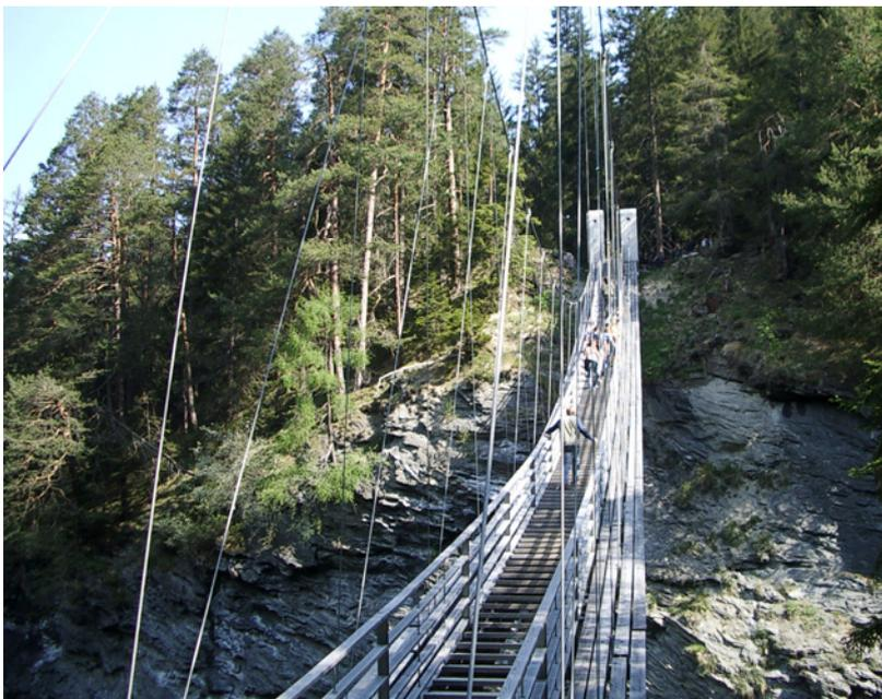
Der Standort der neuen Brücke ist bewusst ca. 70 Meter in Richtung Rhein verlegt worden, um die Gefahr einer erneuten Zerstörung zu minimieren. Die Spannweite beträgt 60m, die Breite 2,60m. Hier ist zu erwähnen, dass die Brettschichtholzträger dieser Breite weitestgehend den direkten Blick in die Tiefe verhindern und so das Maß an Behaglichkeit erhöht. Außerdem erfüllen die Brett-
